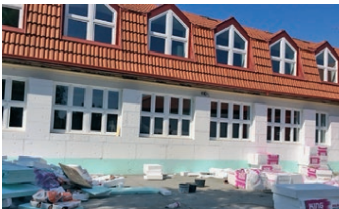
Arany János Általános Iskola szigetelése
