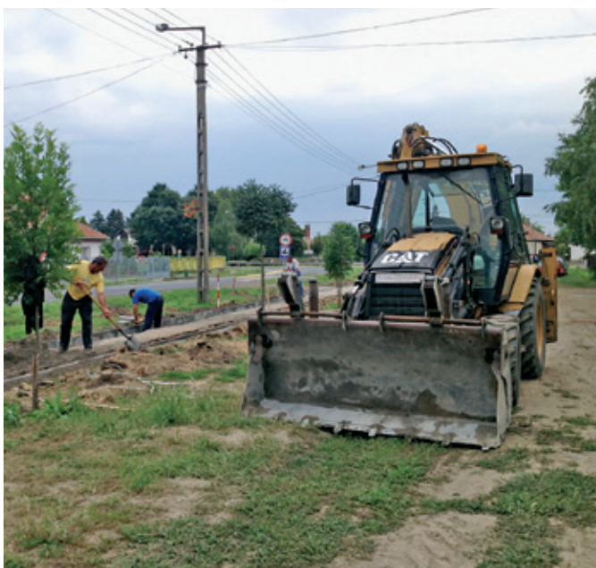
A Szecsői úti járdafelújítás munkálatai megkezdődtek
