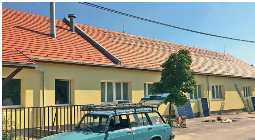
Felkerültek a napelemek tetőtartói az újtelepi óvoda megújult cseréptetőjére
