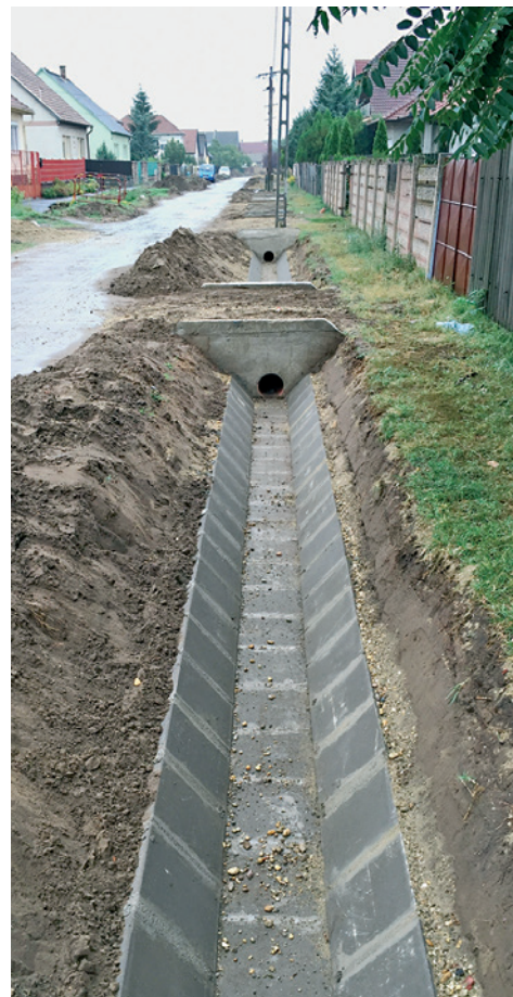
Folyamatban a beton mederlapos vízvezető rendszer kialakítása a József Attila utcában
