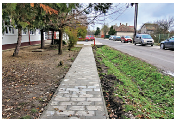
Járdaépítés a Battha Sámuel utcában
