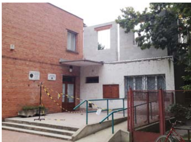
A könyvtár új emeleti épületrészének falazása
